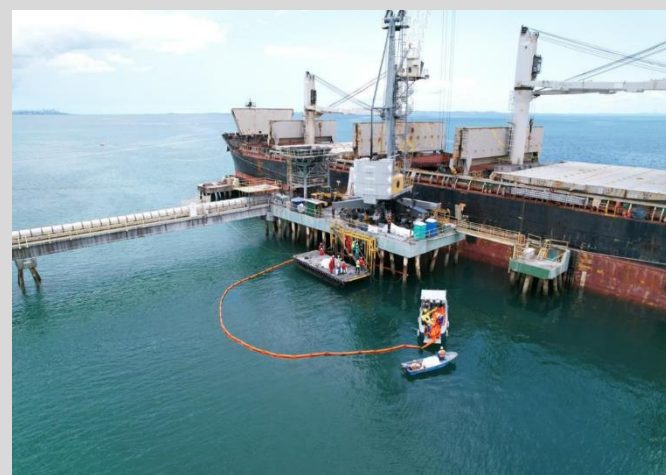
Figura 5: lançamento das barreiras de contenção;
