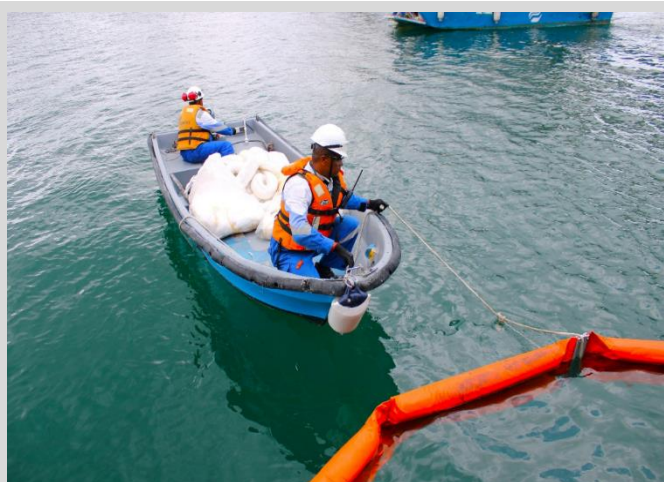
Figura 7: Início da ancoragem do cerco
